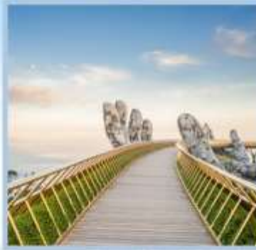
สะพานมือกองคำ
